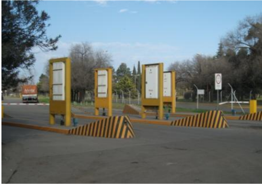
Fig. 1. Portales de medición de chatarra a la entrada de una acería.
