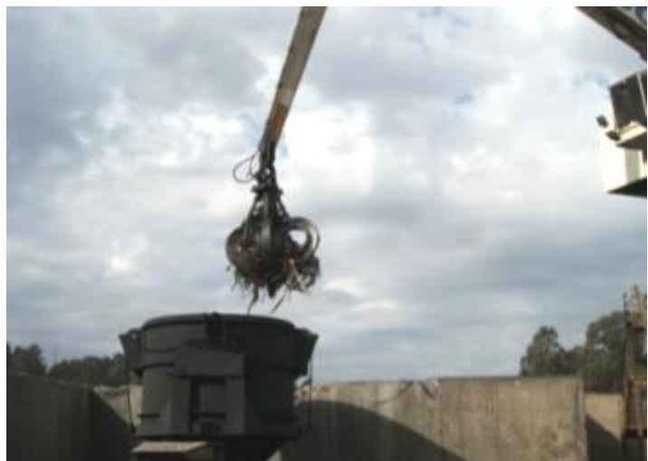
Fig. 4 Carga de chatarra dentro de una cesta.
